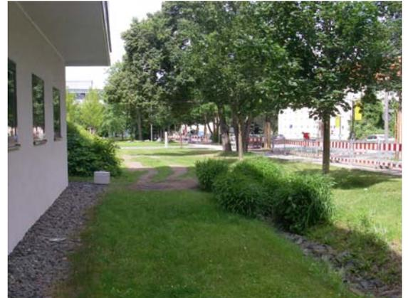
*Rigole zur Regenwasserversickerung und -rückhaltung*
