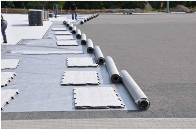
*Sportplatzbau mit nachhaltigem, kostengünstigem Drainagesystem + Komplettersickerung Regenwasser in Rigolen*
